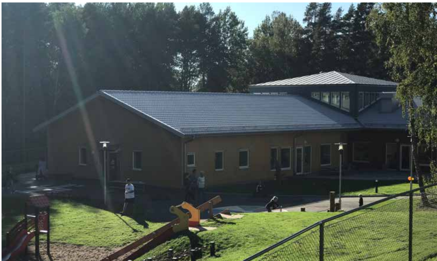
Under 2018 har Gnesta förvaltning uppfört en sex avdelningar stor förskola i Gnesta, förskolan Fågeldansen. Förskolan har solpaneler på taket.
