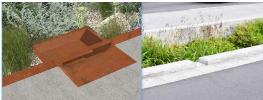
Figur 15. Inlopp av dagvatten i kantstensrad, två exempel
