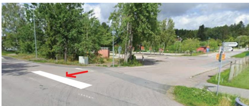
Principillustration som visar hur infarten till skolan och planområdet kan åtgärdas för bättre siktförhållanden vid utfart på väg 57.
