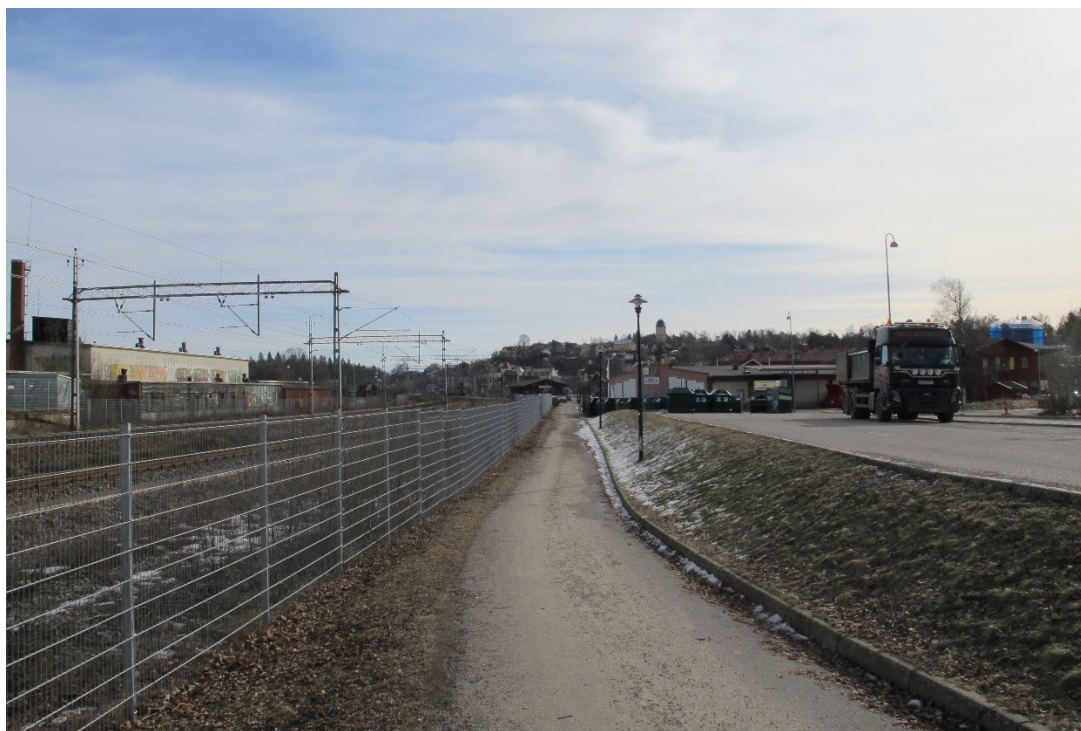
Befintlig nivåskillnad längs delar av spårområdet
