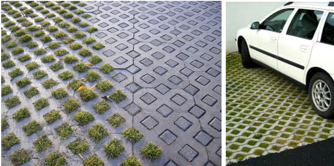
Markparkering för bil inom planområdet ges en delvis grön och genomsläpplig markbeläggning i exempelvis gräsbetong
