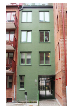
Fasad i grön puts
