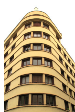
Fasad i gul puts
