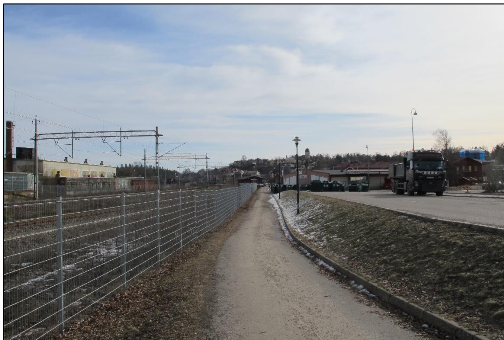
Figur 2-8: Vy 1, befintlig situation utmed spårområdet.
